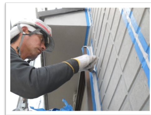
専門業者1による補修
