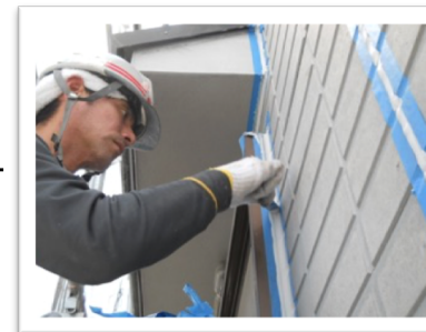
専門業者1による補修
