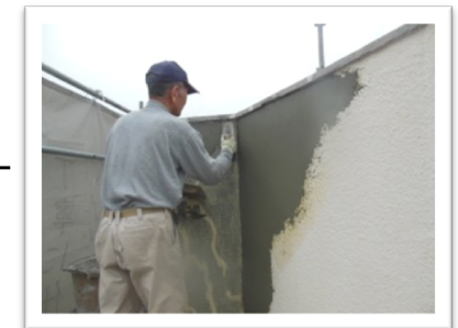
専門業者2による補修
